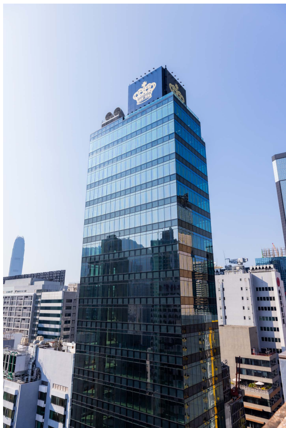
GF Tower 廣發大廈
