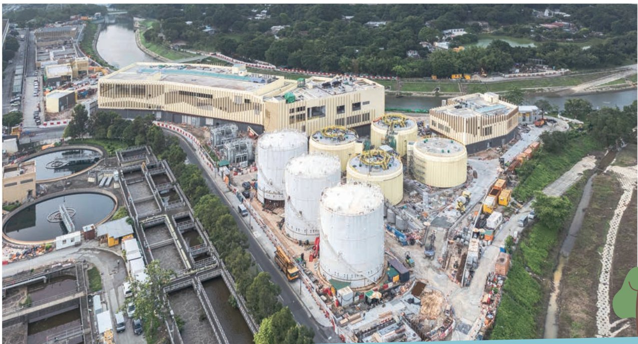
Shek Wu Hui Effluent Polishing Plant – Main Works Stage 1 – Civil Works for Sludge Treatment Facilities and 132kV Primary Substation 石湖墟淨水設施 – 主體工程第一階段 – 污泥處理設施及 132kV 主變電站的土木工程
