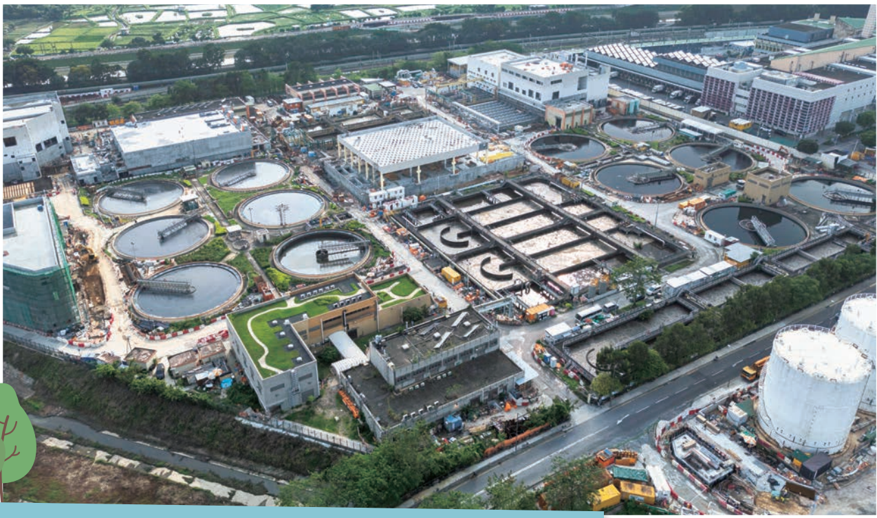
Shek Wu Hui Effluent Polishing Plant – Main Works Stage 1 – Civil Works for Sewage Treatment Facilities 石湖墟淨水設施 – 主體工程第一階段 – 污水處理設施的土木工程
