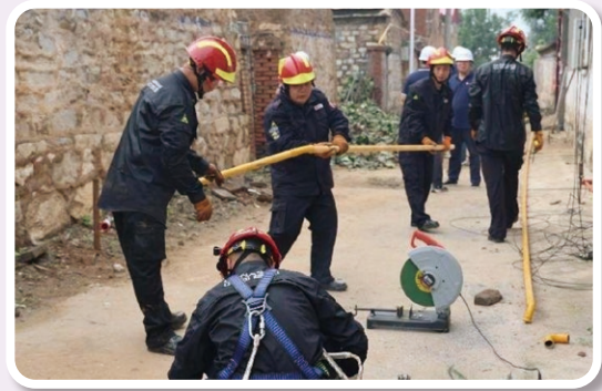
圖：燃氣作業工人搶修氣代煤天然氣管道
