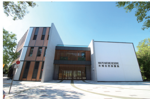
合約工程－米埔自然保護區 斯科特野外研習中心改善工程
