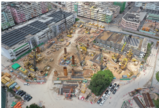
馬頭角之地基打樁工程
