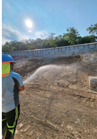
噴水作業，防止粉塵
