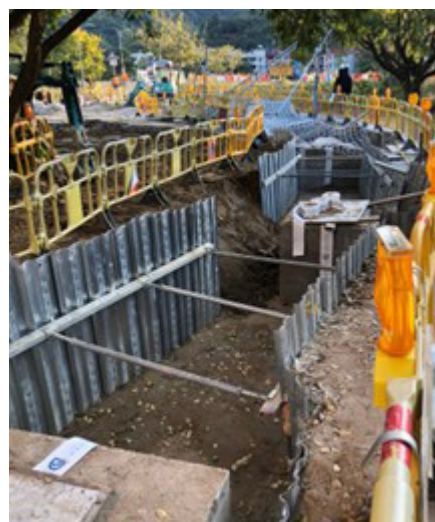
建造污水系統
