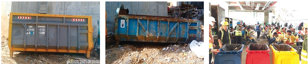
工地分類和回收廢物
