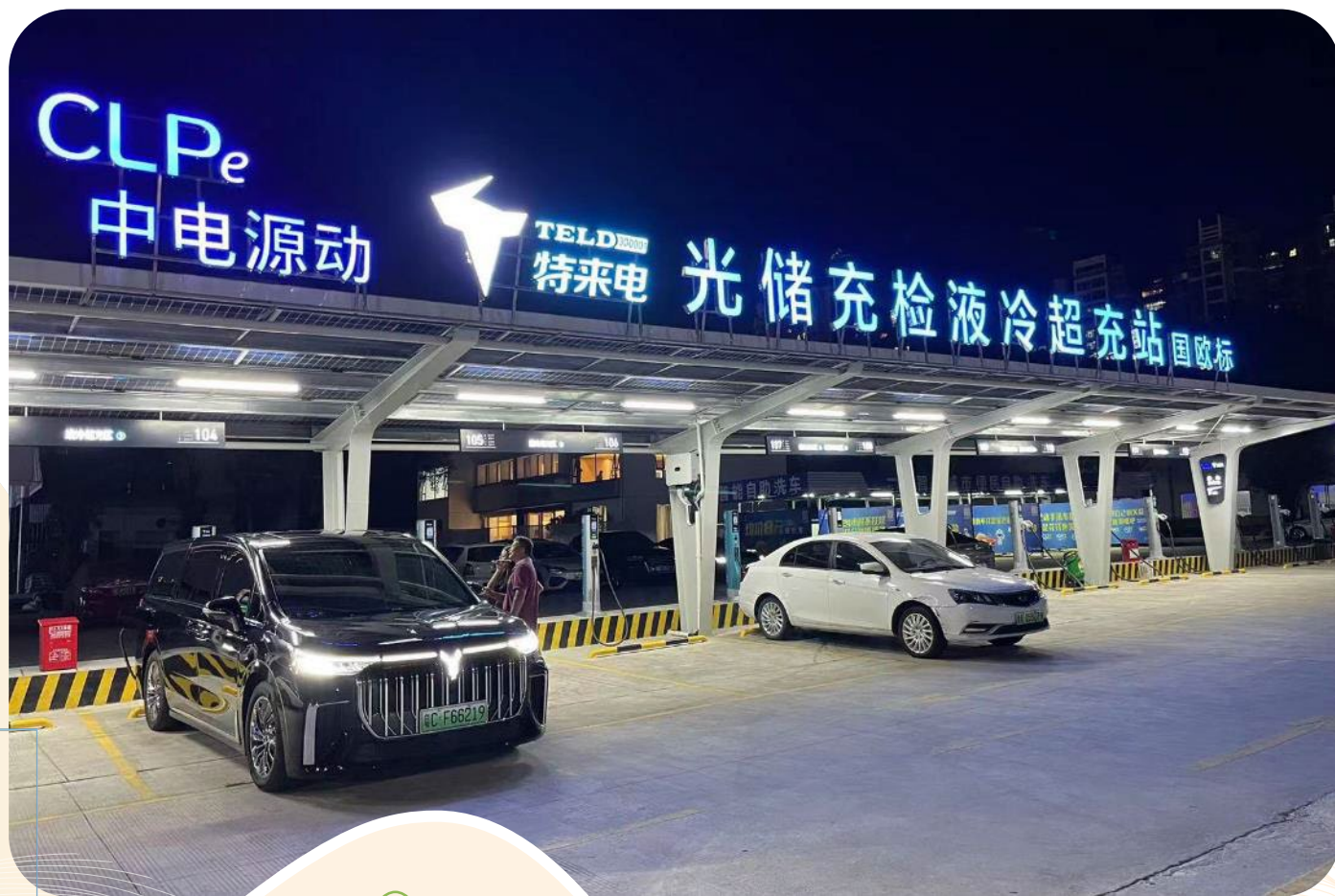
位於中國內地珠海的「光儲充檢」液冷超充站。
