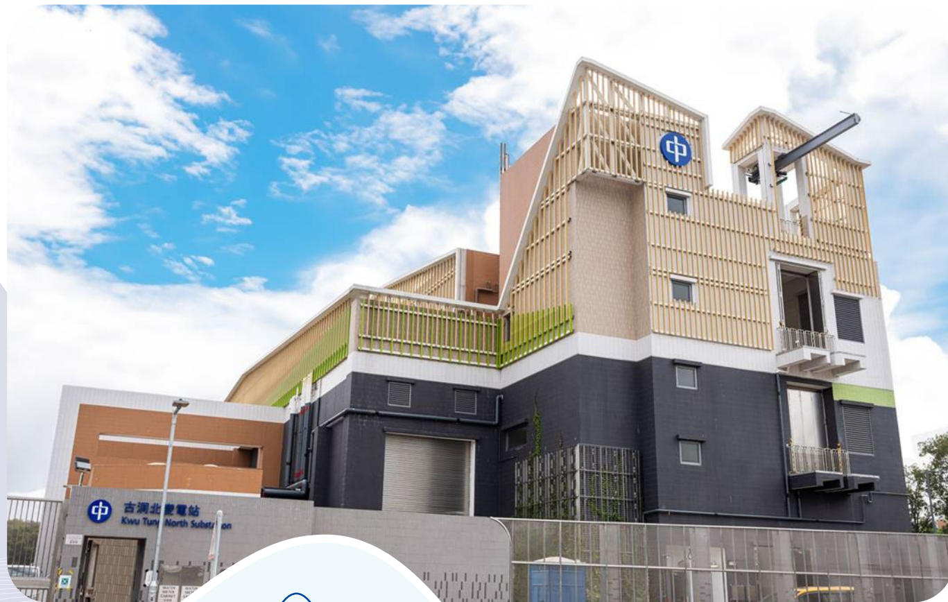
香港北部都會區的古洞北變電站。
