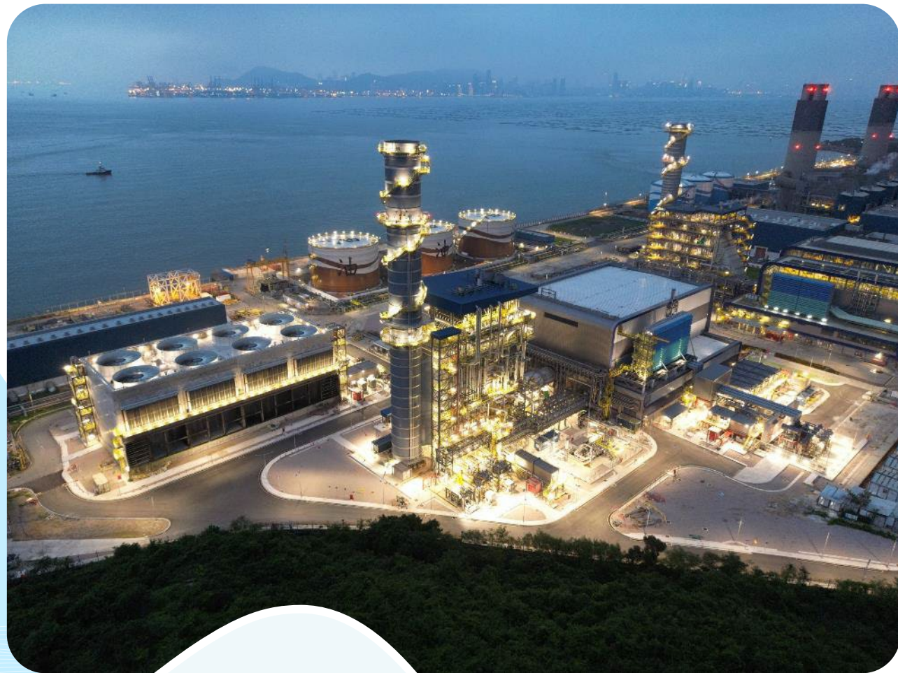
香港龍鼓灘發電廠的聯合循環燃氣渦輪發電機組D2。
