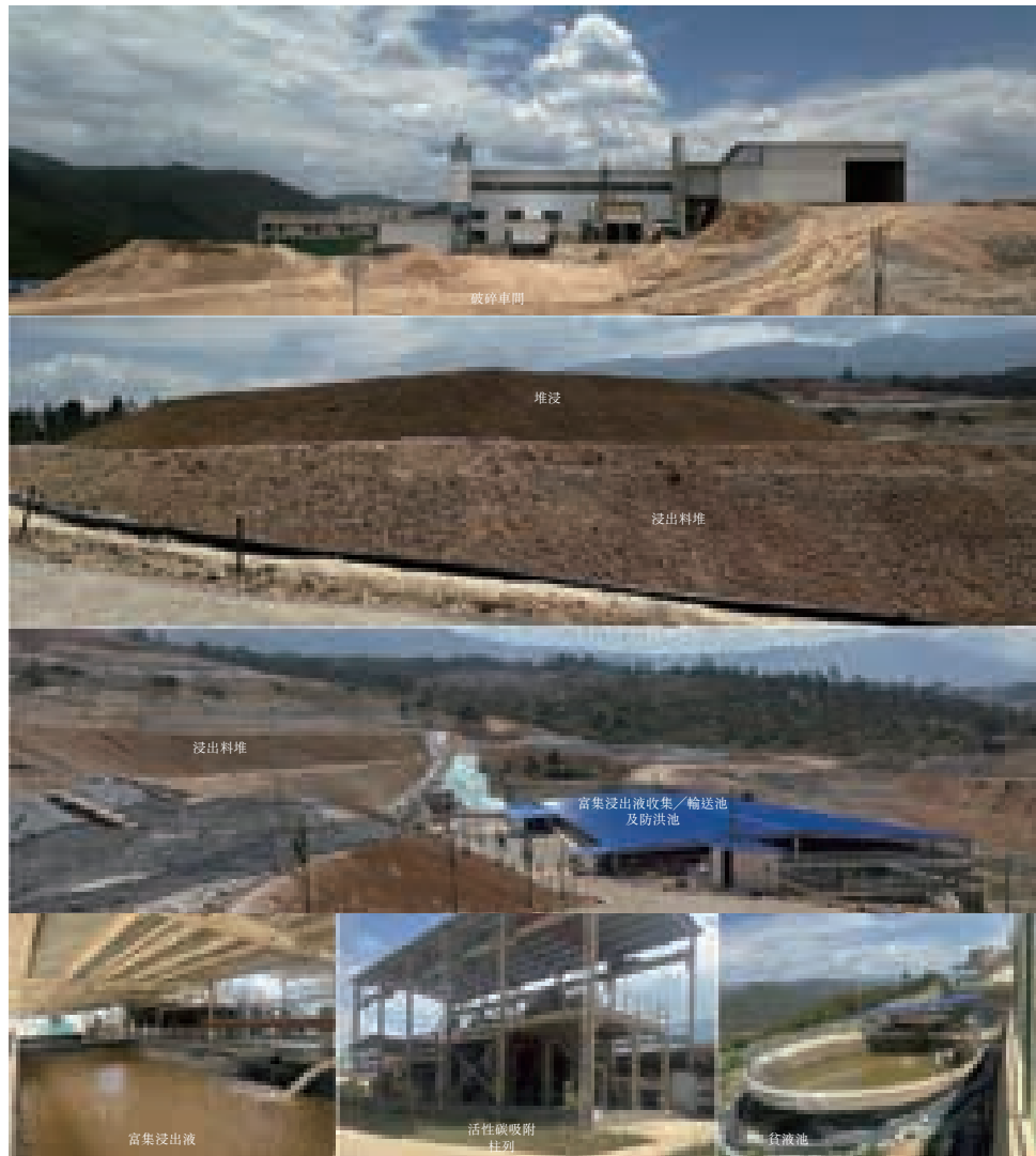
圖11-15：溪燈坪堆浸廠的主要設施照片
