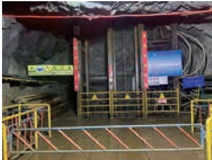
圖10-22：東風上部採區平硐層豎井通道
