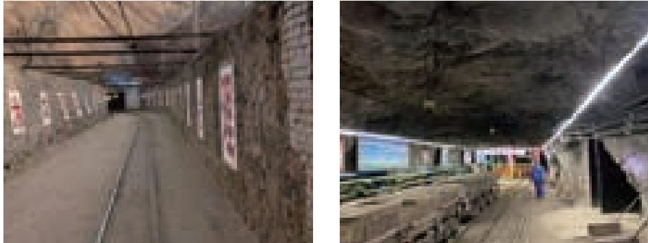
圖10-6：五中段主平洞入口及井底車場照片
