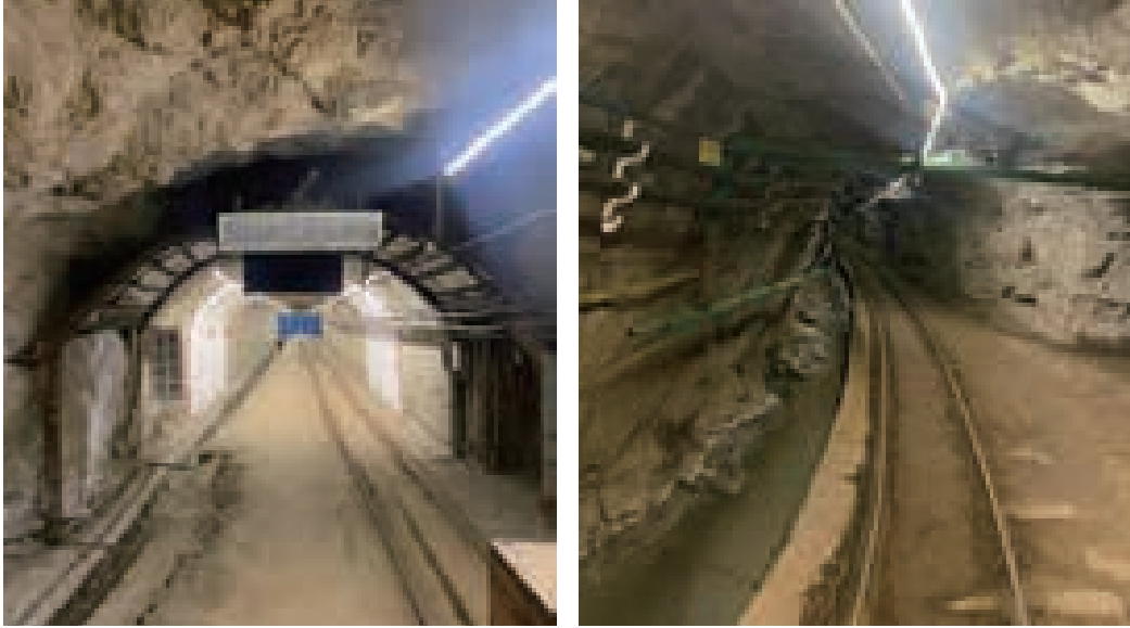
圖10-20：東風礦三中段平硐通道及巷道照片
