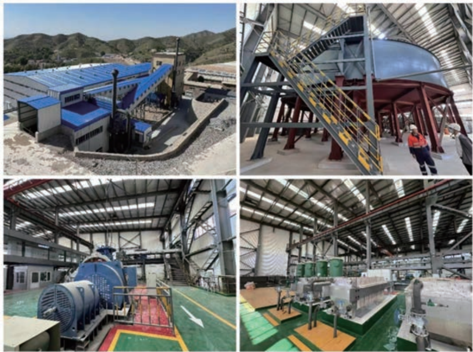
圖 11-3：吉隆 2 廠現場照片
