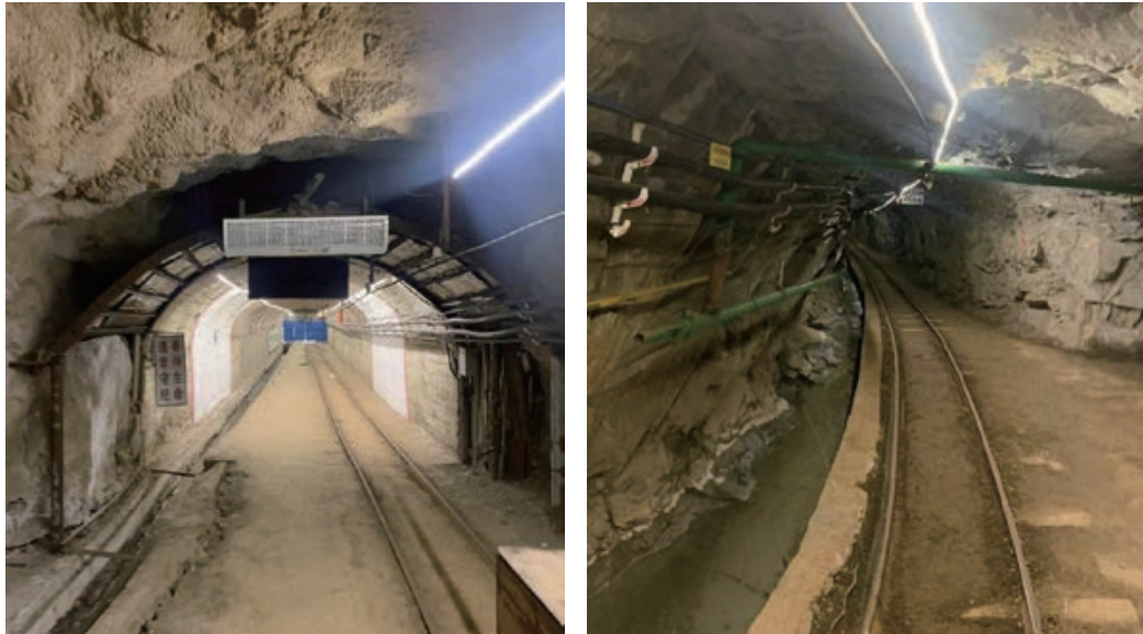
圖10-20：東風礦三中段平硐通道及巷道照片
