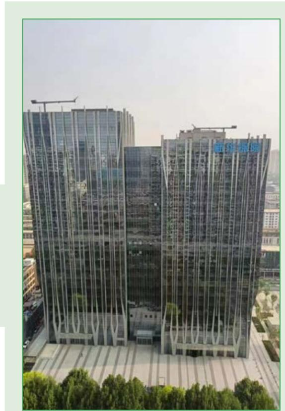
▶ 中桐廣場是位於石家莊裕華路迎賓大道金融創新中心的地標建築，玻璃幕牆採用中空 LOW-E 雙銀鍍膜超白玻璃，反光率小於 30%，既保證冬暖夏涼又能有效減少光污染。空調採用燃氣直燃型溴化鋰吸收式冷熱機組，利用熱能為動力節約能耗，可明顯節約電能。
