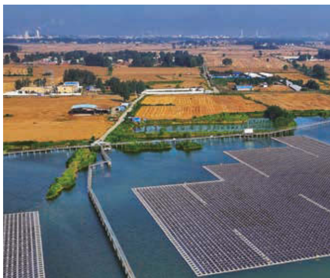
▲ 本行安徽省分行支持的綠色金融項目——宿州水上漂浮式光伏發電站
