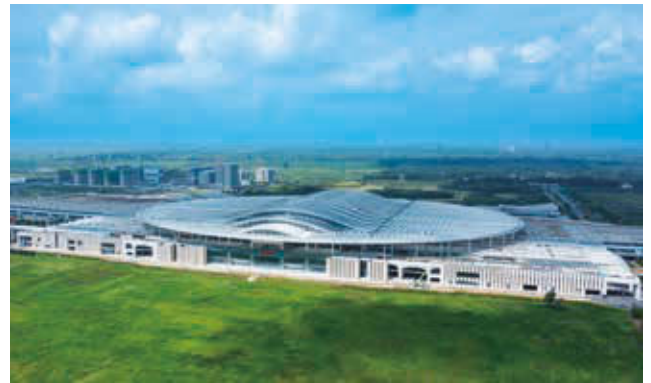
▲ 本行支持的京雄城際鐵路項目
