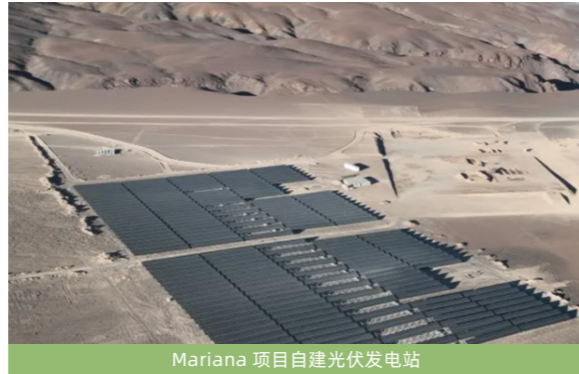
Mariana 项目自建光伏电站
