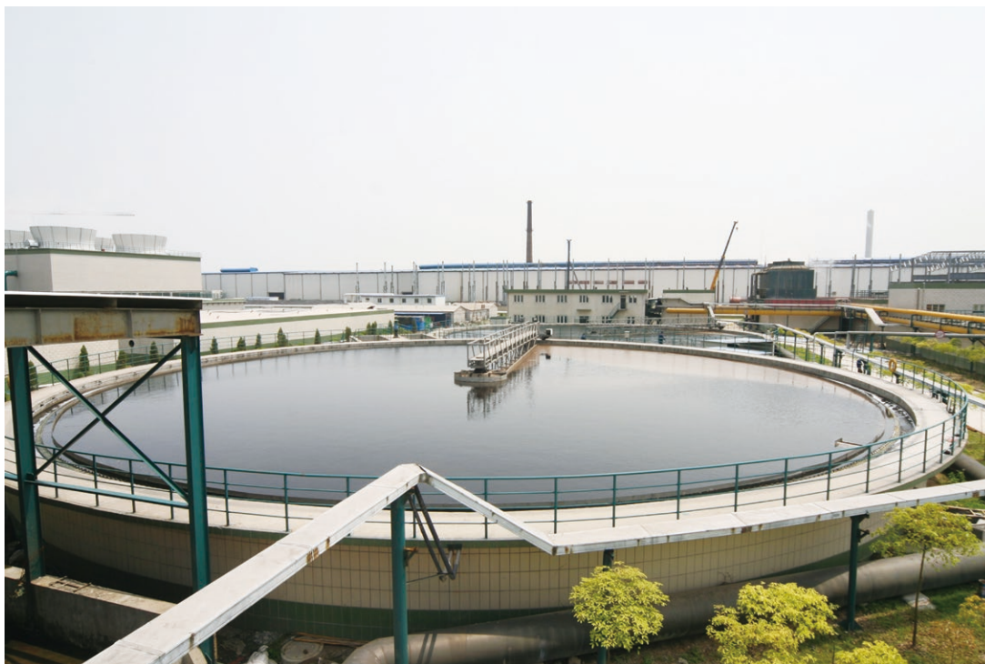
Sewage treatment station 污水處理站
