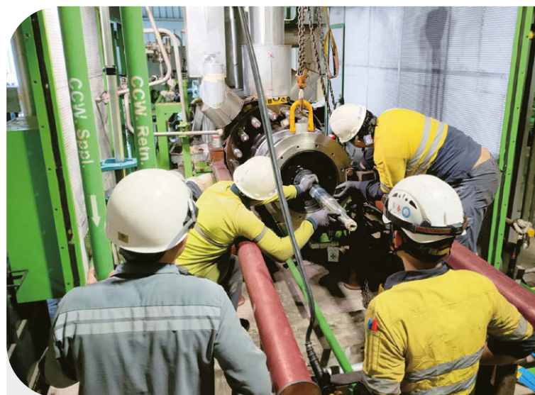
► RPCL 的技術人員移除鍋爐供水泵上的濾芯，以提高可靠度。
