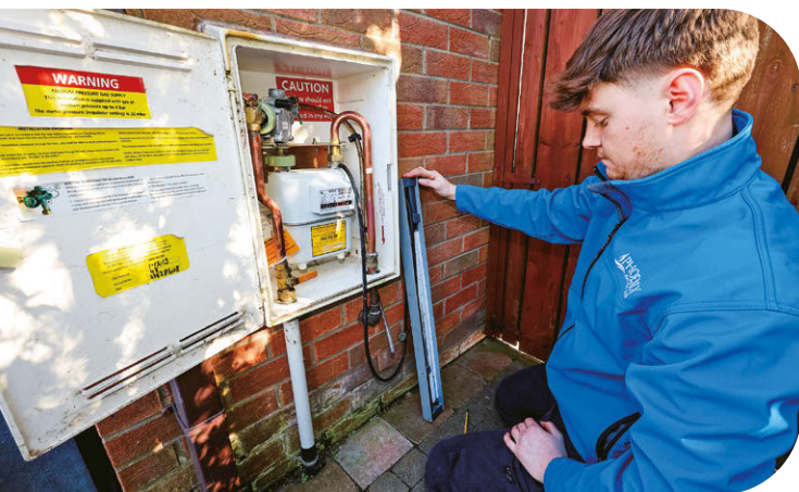
Phoenix Energy 的工程師正在檢查客戶的氣表。
