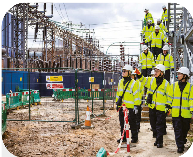
工作團隊巡視倫敦西南部溫布頓的工地，了解工程進度。
