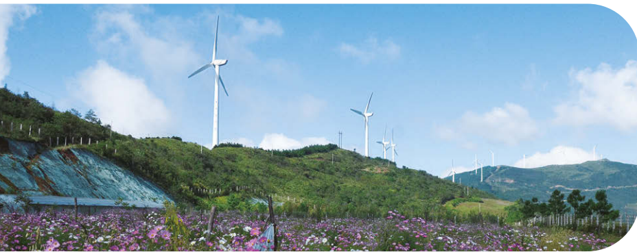
► 大理風力發電場設有64台750千瓦的風力發電機，所產生的可再生能源電力有助減少雲南省的碳排放。
