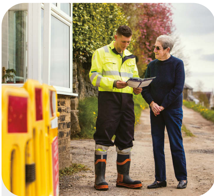
NGN 工程師與居住在西約克郡哈利法克斯，毗鄰配氣管道更換工程工地的居民交談。
