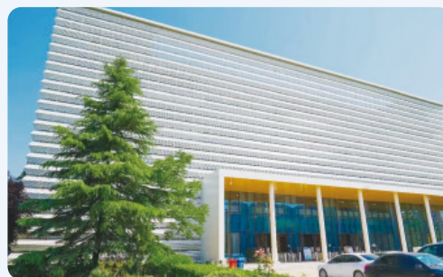
某服裝工程學院新建教學樓
