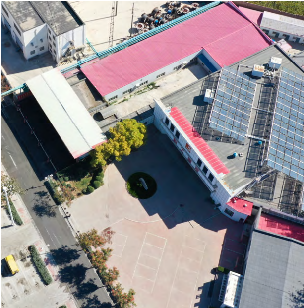
新城金礦安裝太陽能熱水單元組
