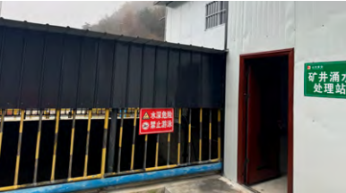
西和中寶礦井湧水處理站
