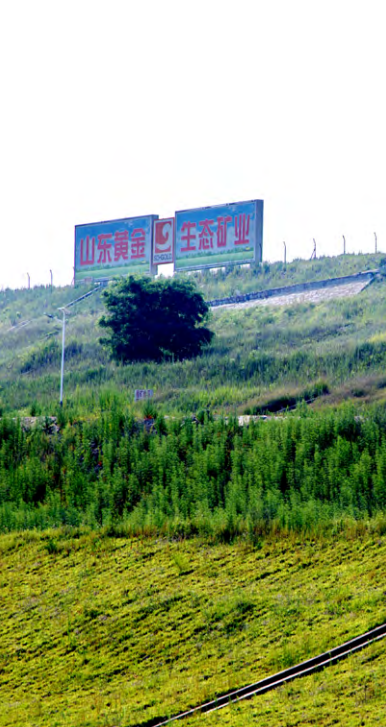
三山島金礦尾礦庫治理
