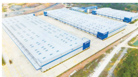
38 Nanning Jingkai Project
