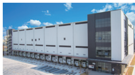
12 SZI Cold Chain (Nanjing Jiangning)
