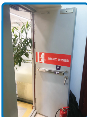
Safety Exit 安全出口提示
