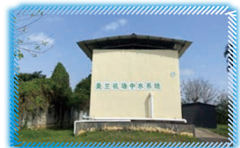
Reclaimed water reuse system 中水回用系統
