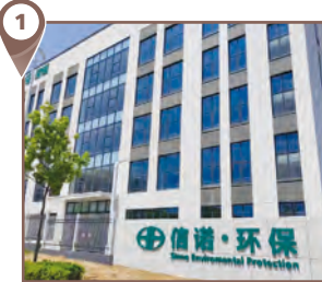
位於山東青島的化學氣體治理 設備廠房 The chemical vapour treatment equipment plant in Qingdao, Shandong
