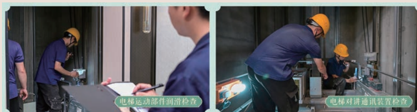
電梯維保現場 Elevator Maintenance Site
