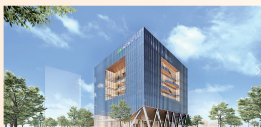
Guangzhou • Glodon Digital Technology Building (廣州 廣聯達數字科技大廈)
